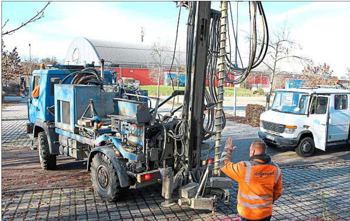
An der Parkharfe vor der Saturn-Arena führt eine Baufirma gerade Probebohrungen durch: Es sind vorbereitende Arbeiten für die neue Unternehmenszentrale der VR-Bank Bayern-Mitte. Die plant das Architekturbüro Schulz und Schulz aus Leipzig für die Genossenschaftsbank. Foto: Eberl/Entwurf: Schulz und Schulz
